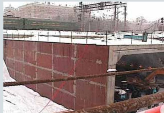
Рис. 9. Сооружение тоннеля под насыпью методом продавливания
