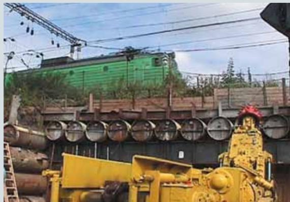
Рис. 8. Сооружение тоннеля под защитой экрана из труб [5]
