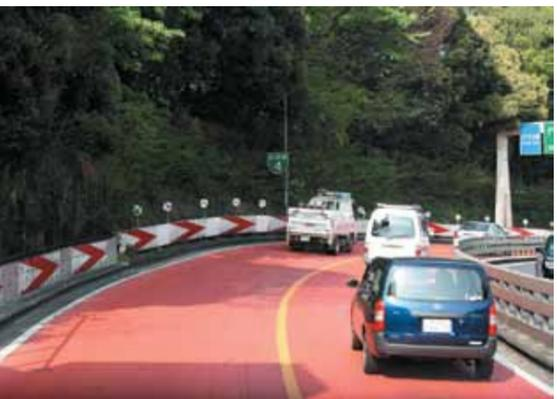
Фото 6. Проезжая часть, выделенная красным асфальтобетоном
