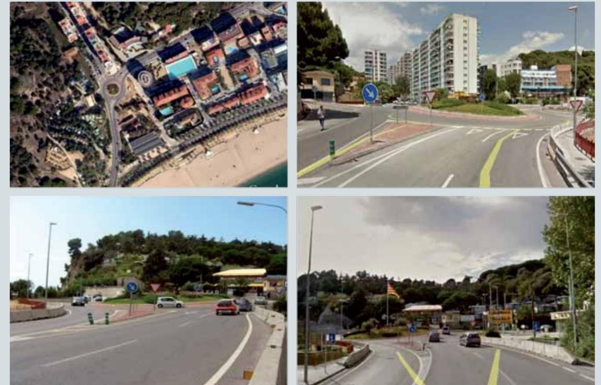
Рис. 6. Кольцевое пересечение на въезде в населенный пункт (Испания), автомобильная дорога с интенсивностью 5-6 тыс. авт. / сутки
